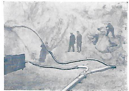
Fig. 5. — Exploitation de carrières de sable par jet d'eau.
