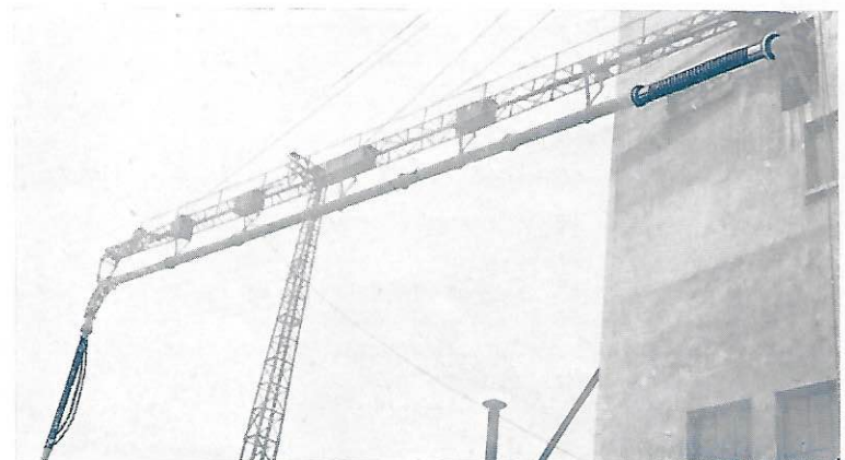
Fig. 20. — Bras mobile de portique aspirateur (silos à grains).
