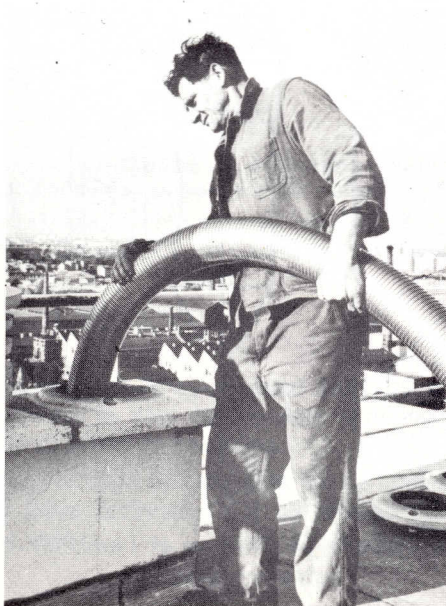
Mettre en place FUMINOX par le haut... ..ou par le bas
